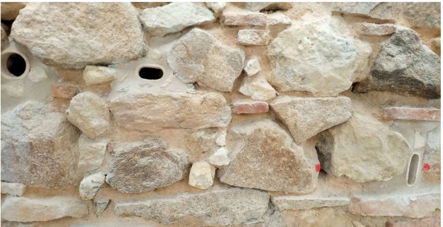
Piezas cerámicas para emboque de nidos para primilla, vencejo y murciélago diseñados y ejecutados por GREFA en la restauración de la muralla de Segovia.
