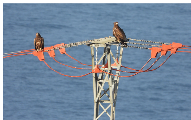
Dos de los pigargos liberados posado en un apoyo eléctrico corregido para evitar electrocuciones de pigargos y otras aves.
