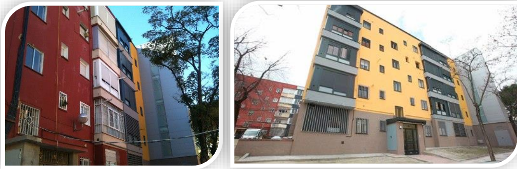
Edificio antes (izquierda) y después (derecha) de la rehabilitación
