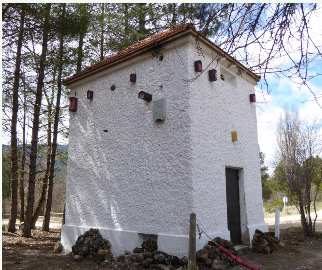
El Grupo de Rehabilitación de la Fauna Autóctona y su Hábitat (GREFA) colaboró con Naturgy en la restauración de casetas de transformadores en desuso como lugares de reproducción y refugio a diferentes especies silvestres, creando de esta manera puntos de biodiversidad.
