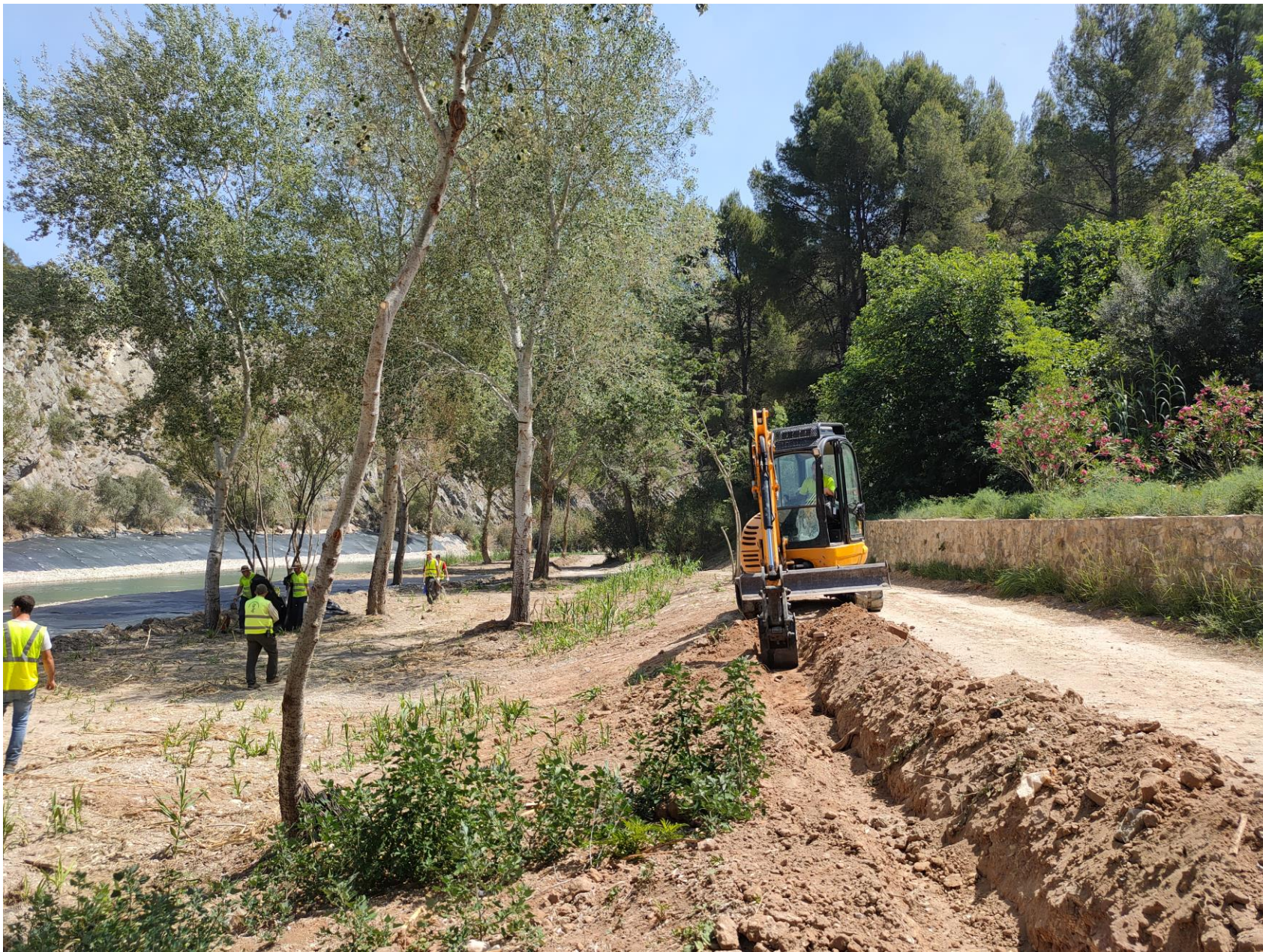
Excavación zanja para cobertura en el río Albaida
