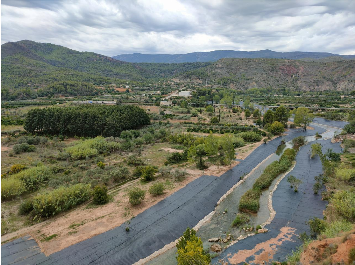
Gestalgar actuación en ejecución, 2023
