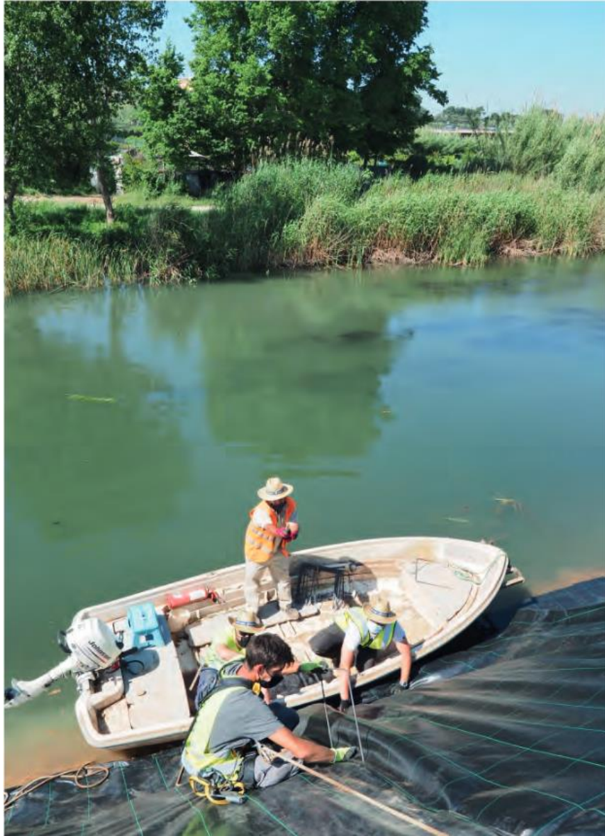
Instalación de cobertura en el río Turia, Manises, 2021
