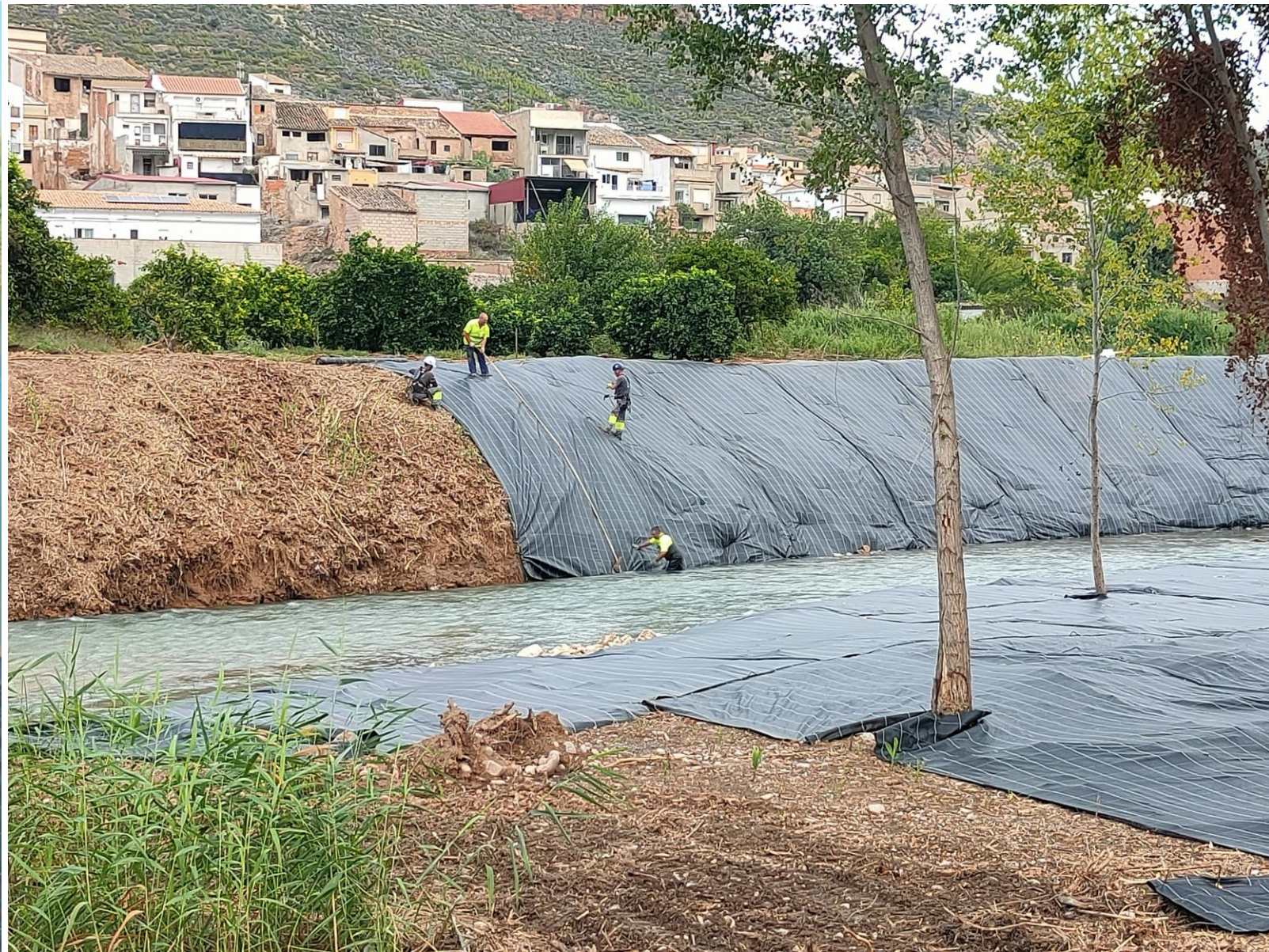
Instalación de cobertura en el río Turia, Bugarra, 2023
